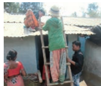
屋根の雨漏りの個所を修繕する住民たち
