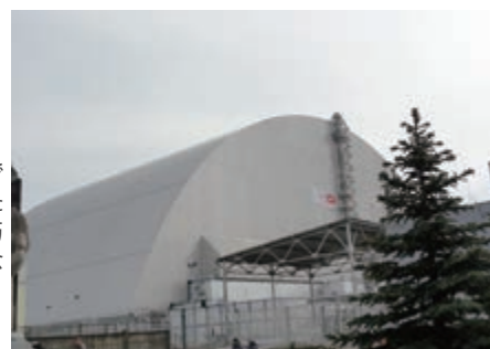
チェルノブイリ原子力発電所で2016年11月29日に設置された巨大な鋼鉄製新シェルター。老朽化による放射性物質漏れが懸念されていた爆発した4号機を覆う。
