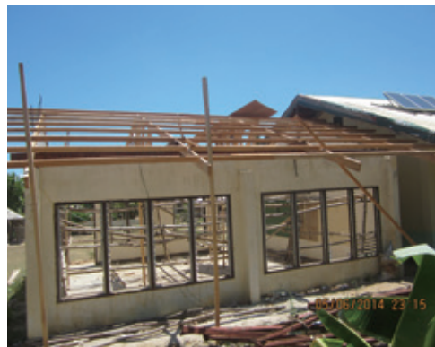
修復工事中の小学校
