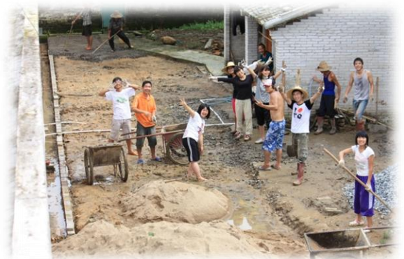
道路舗装のワークをした時の写真☞
