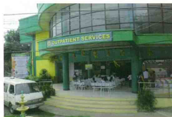
外来棟入口:ドアが無く、開放的です。総合病院でもあるため、施設外からの患者さんも多く来られているようです。
