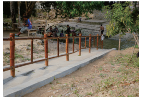
温泉に続く道に手すりをつけ、歩きやすくなりました
