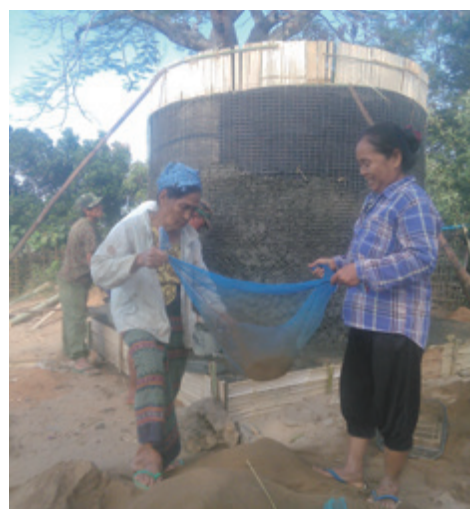
水タンクをつくるために、セメント作りから住民が取り組みます。その過程には、女性も積極的に参加し、住民全体の強いオーナーシップが芽生え、よりよい管理体制も期待されます
