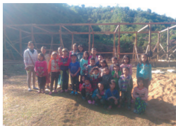
学校建設予定地で、完成を心待ちにしている子どもたち。校舎の支柱となる木材は、周辺の山々から木を伐採して村へ運んできました
