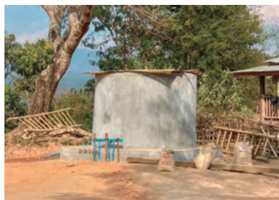
たくさんの水を貯めることのできる水タンクが完成！タンクには竹をつなげて作った水道管をつなぎ、各家庭に水を運びます
