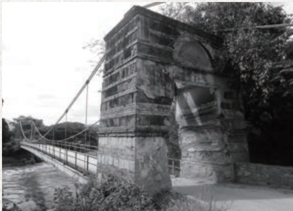
療養所と一般社会を結ぶ唯一の道「嘆きの橋」
